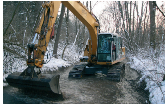
Bagger bei der Kiesumlagerung, geübte Fahrer schaffen mehr als 1000 m 3 am Tag.
